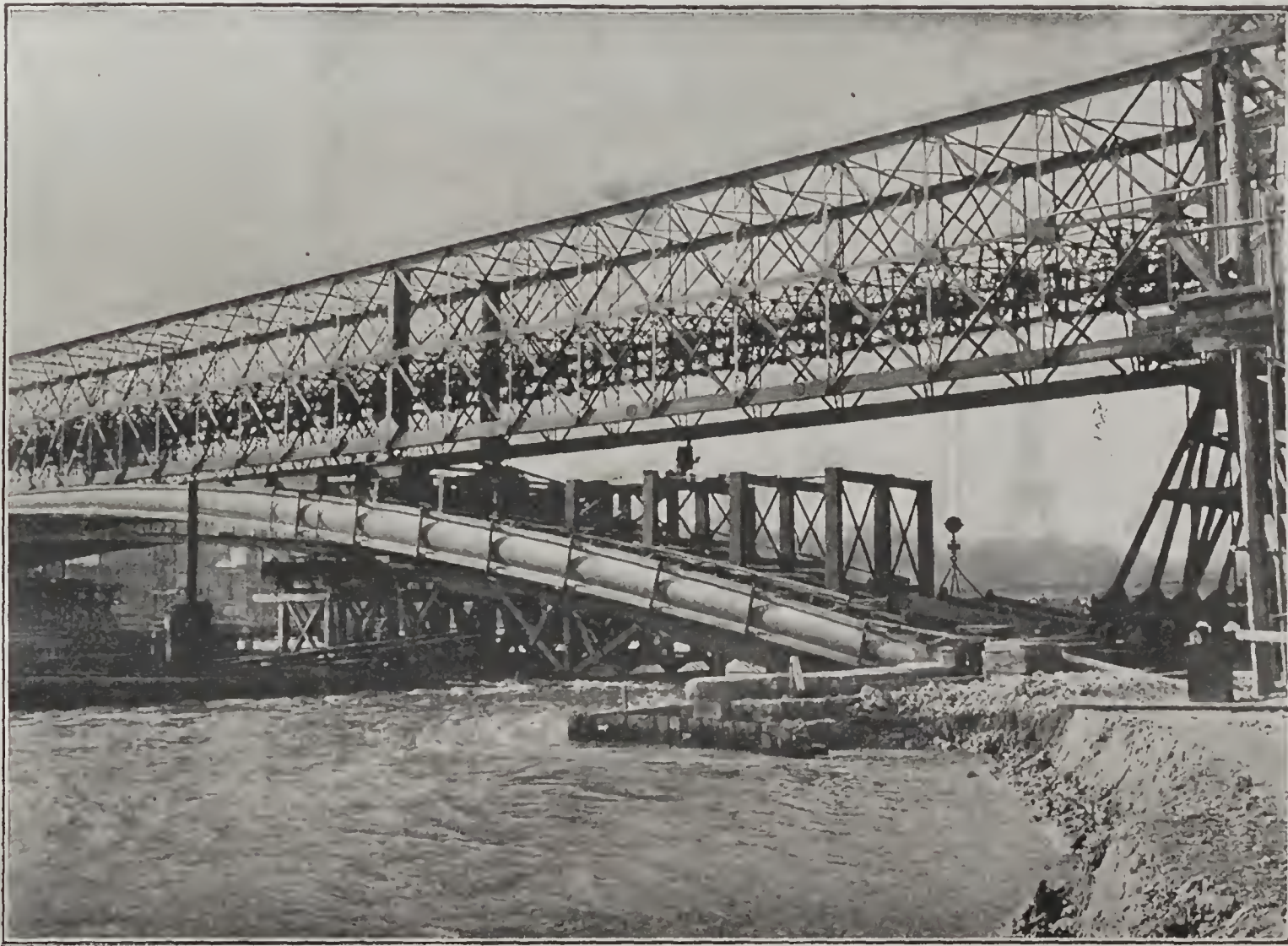
LE PONT ALEXANDRE III. — Montage des supports verticaux (vue d'amont).
